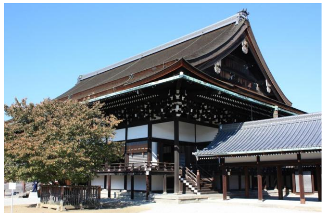
現在の紫宸殿の軒廊（写真右下）
